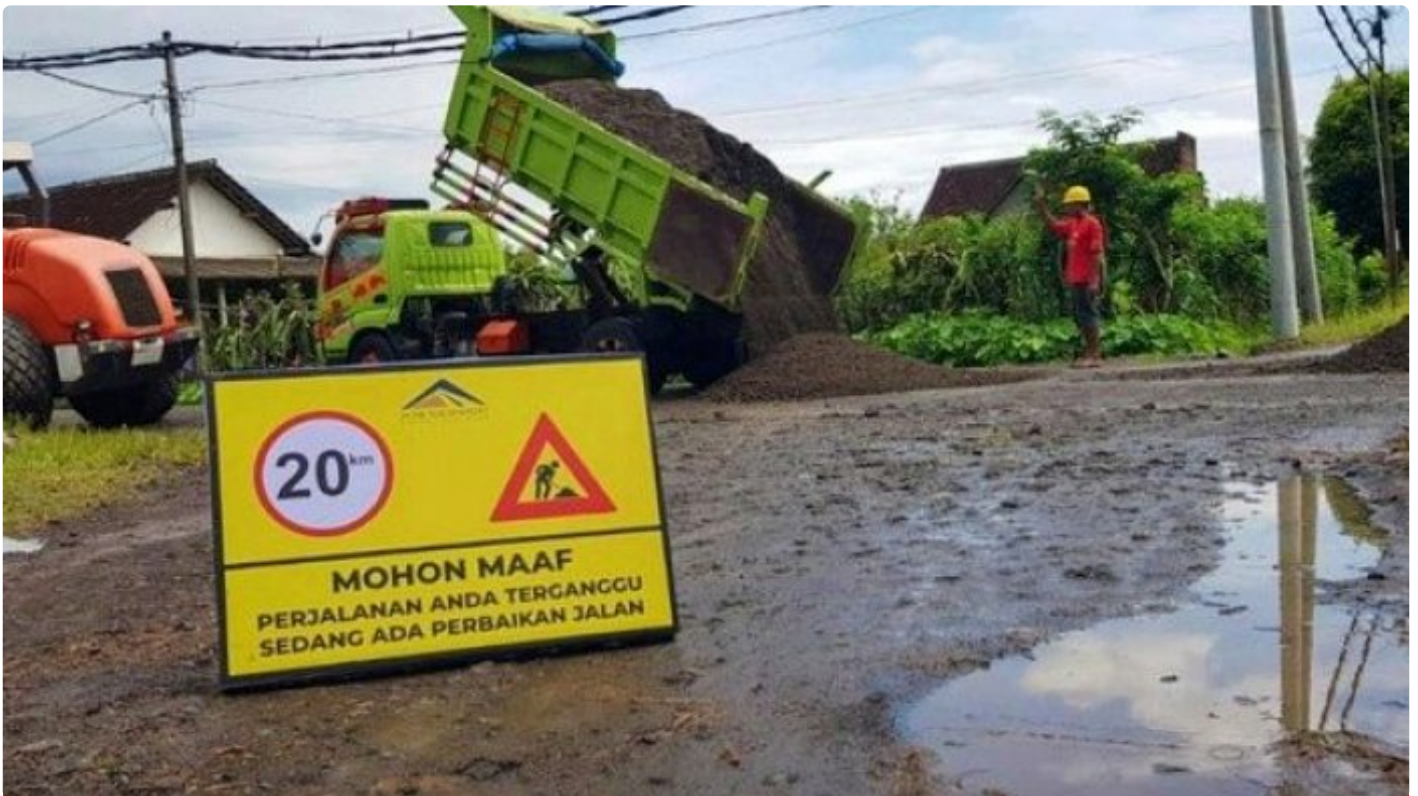
Perbaikan jalan rusak di Banyuwangi
